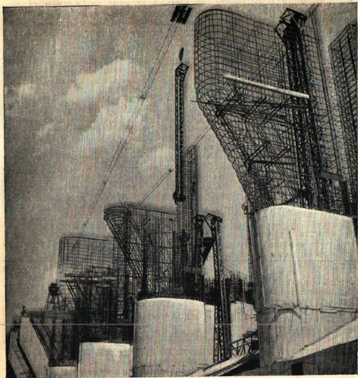
Строительство водосливной плотины.
