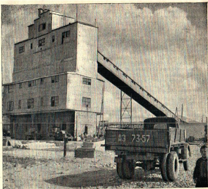
Бетонный завод правого берега.
