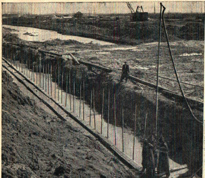
Начало строительства шлюза № 13.
