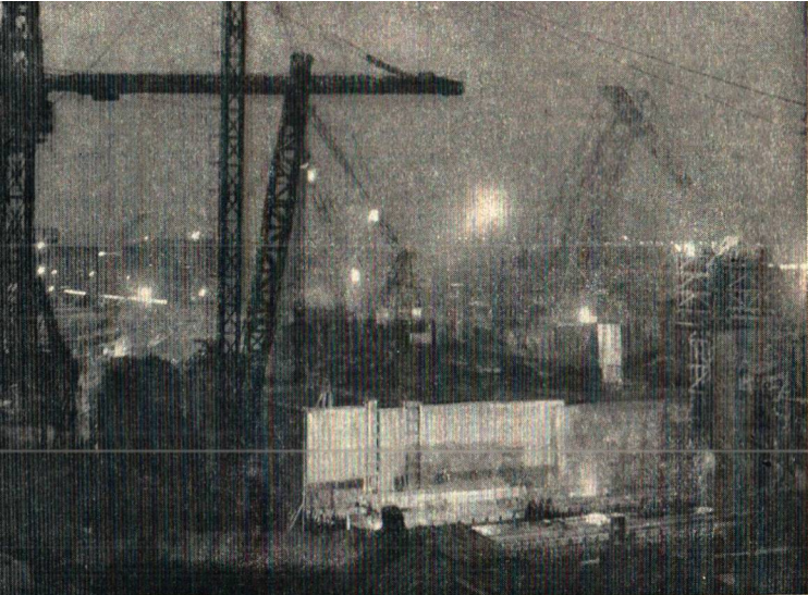
Котлован ГЭС ночью.
