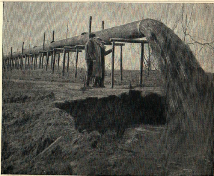
Высокоэстакадный способ намыва.
