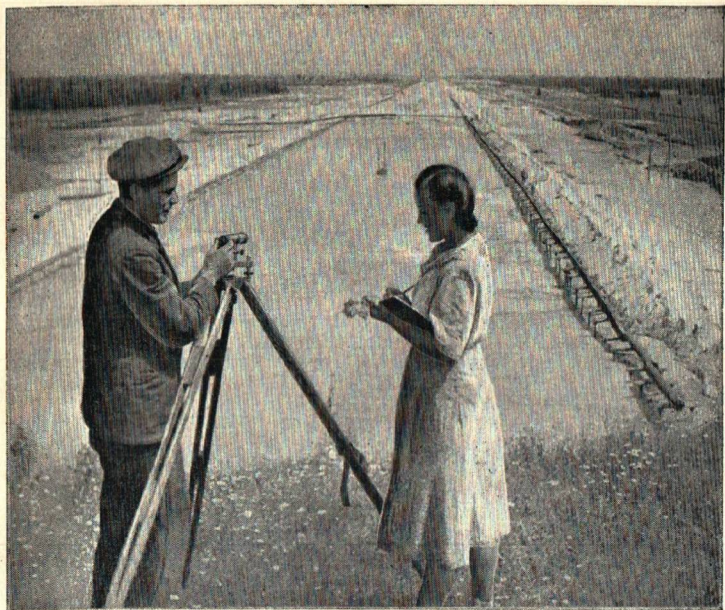
Намыв грунта в тело земляной плотины.
