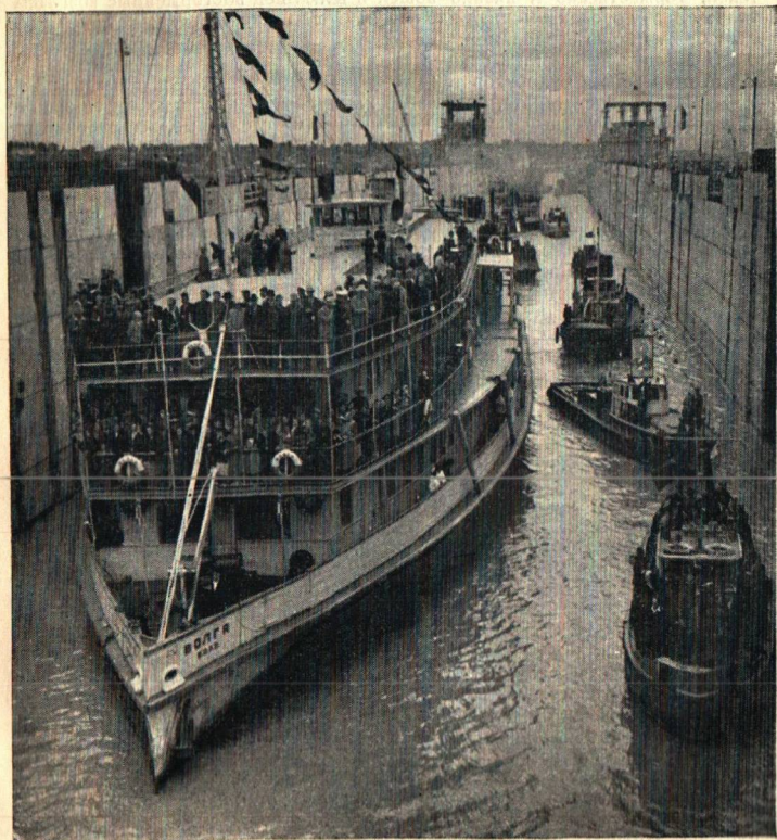
Шлюз № 14. Первое шлюзование.
